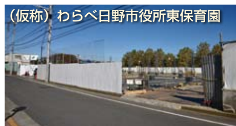
(仮称) わらべ日野市役所東保育園 日野市神明 1-13 定員 152 人
