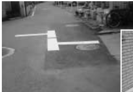
日野本町4丁目地内 マンホール段差補修
