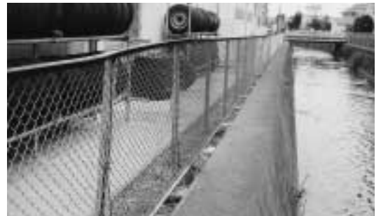
万願寺1丁目地内 転落防止フェンス補修
